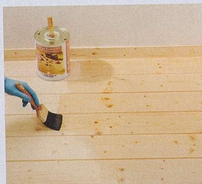
**Olio per parquet** si può stendere sulla superficie del legno usando un pennello o un tampone di stoffa; l'olio va distribuito uniformemente, senza eccedere, per poi passare uno straccio pulito.
