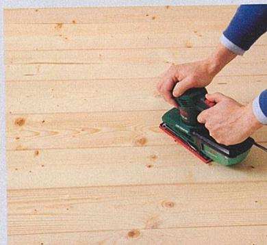
Per ottenere un buon risultato è necessario dare una seconda mano di olio a distanza di almeno 6-8 ore, previa carteggiatura della superficie con carta abrasiva a grana 320.
